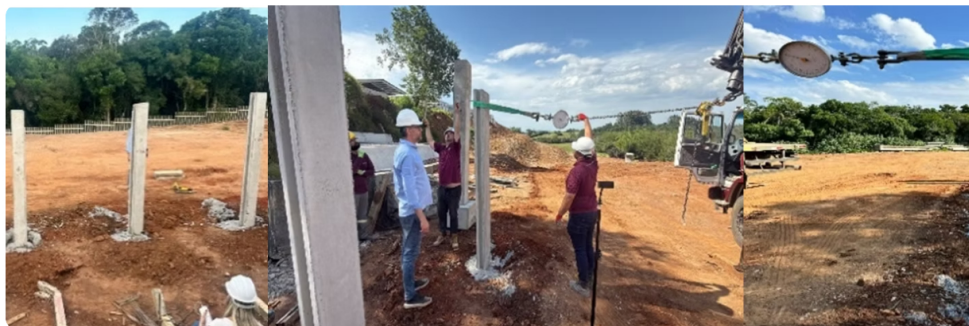
Figura 3 - Disposição dos pilares e início do ensaio de flexão
