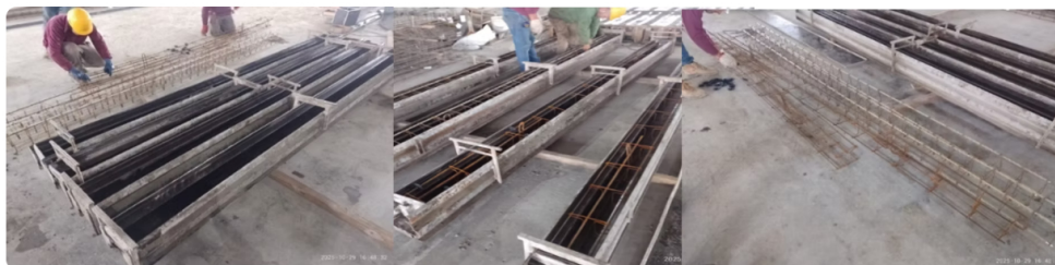
Figura 1 - Detalhe da armadura e formas dos pilares
