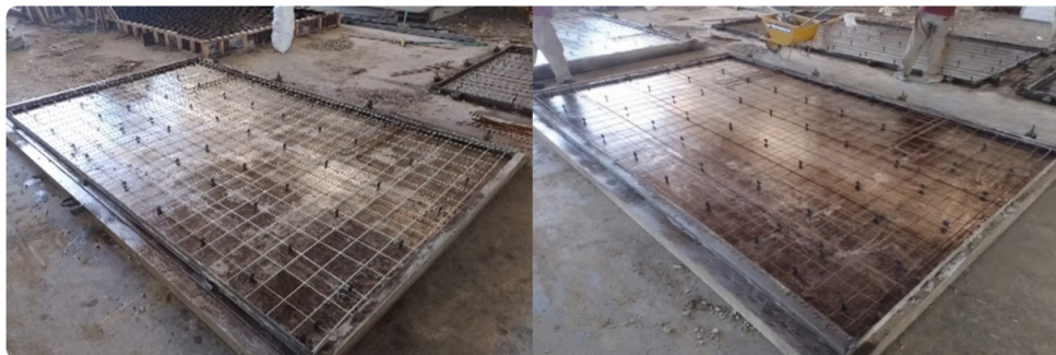
Figura 2 - Armaduras de aço CA-60 e GFRP
