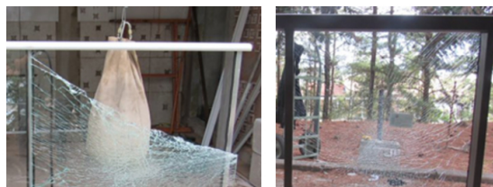
Figura 4. Guarda-corpos após aplicação do impacto
