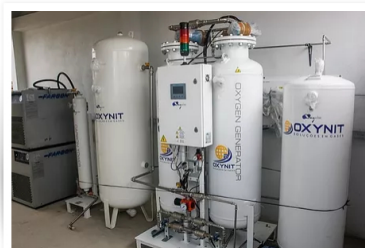
1- Compressor Parafuso (opcional); 2- Compressor Parafuso; 3- Reservatório Ar comprimido; 4- Filtros Coalescentes 5- Secador por Refrigeração; 6- Concentrador Oxigênio; 7- Reservatório Oxigênio
